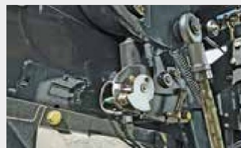
Электрическая система обвязки
